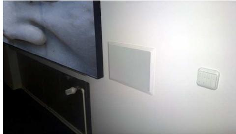
Auch eine Unterputz Installation ist möglich (**Stealth Acoustics**) – hierbei werden Lautsprecher mit speziellen Exitern an eine verputzbare Platte angekoppelt welche schon bei der Konstruktion des Hauses eingebaut wird. Diese Lautsprecher sind somit völlig unsichtbar – die plane Oberfläche lässt sich tapezieren oder sogar fliesen.
